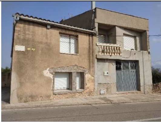
Façana habitatges existents
