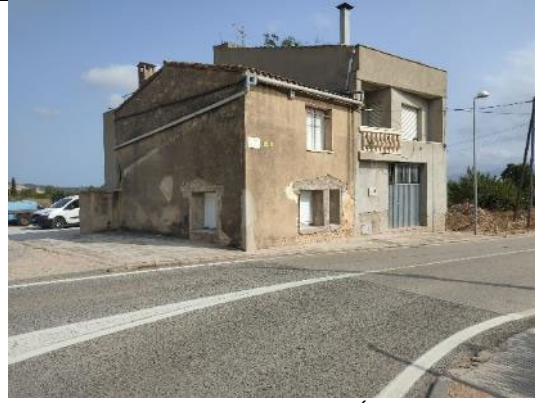
Habitatges existents a l'Av. Don Álvaro 258-260
