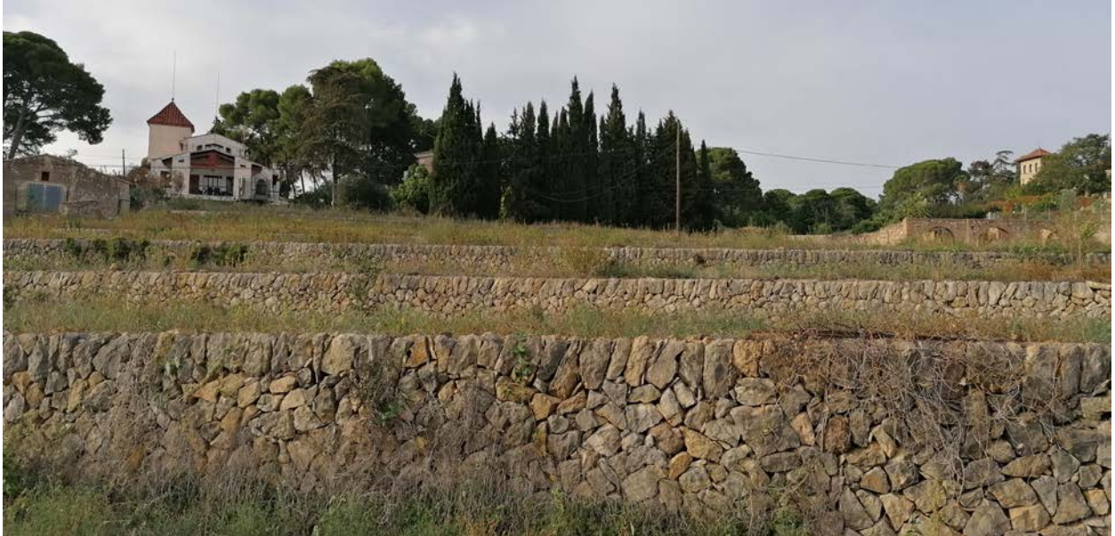
Finca 2. Vista des de l'interior, últim bancal, cap al nord. Bancals de murs de pedra seca.
