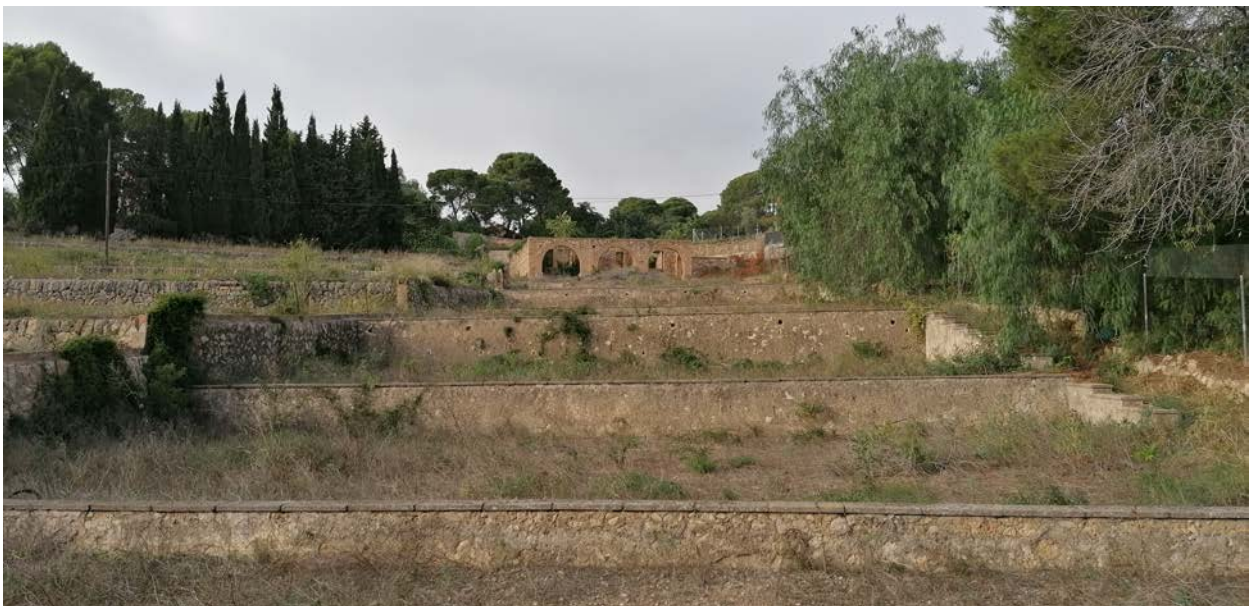
Finca 1. Vista des de l'interior, últim bancal, cap al nord. Bancals de murs de pedra amorterada.
